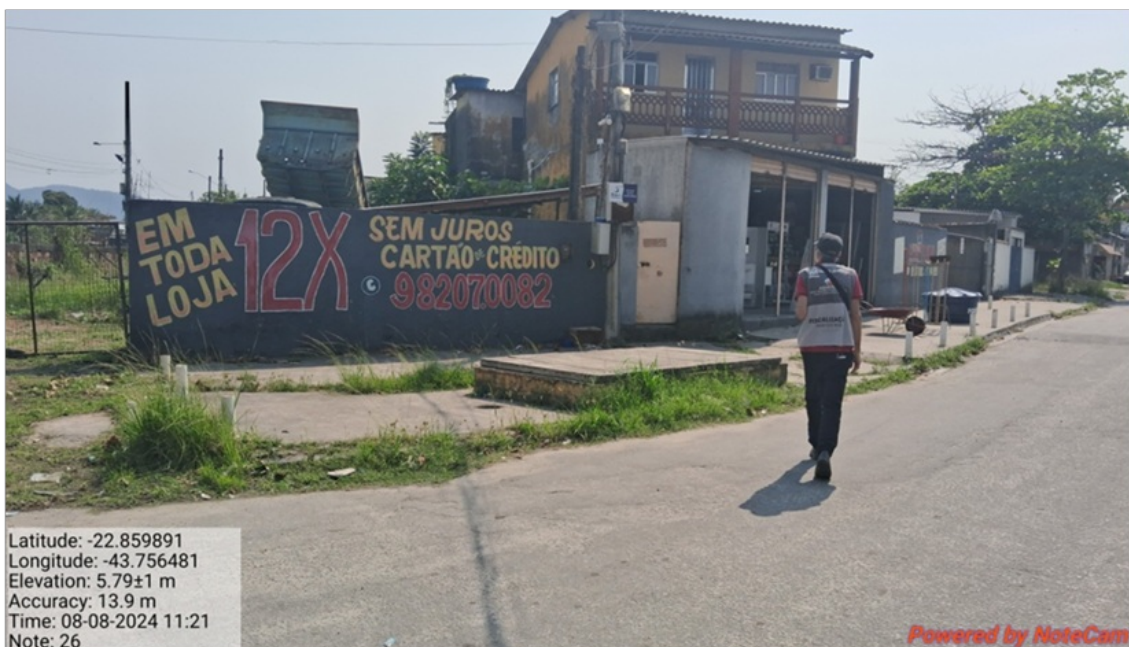
Foto 1 – Vista geral da estação e seu entorno. Destaca-se o desnível entre o poço e o passeio, sujeito a ocorrência de acidentes, e a presença de vegetação ao redor do poço.
